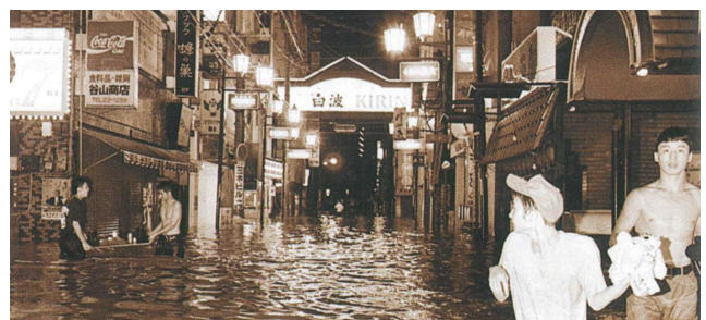
8・6水害 繁華街にも濁水が流れこんだ 写真提供: 南日本新聞社
